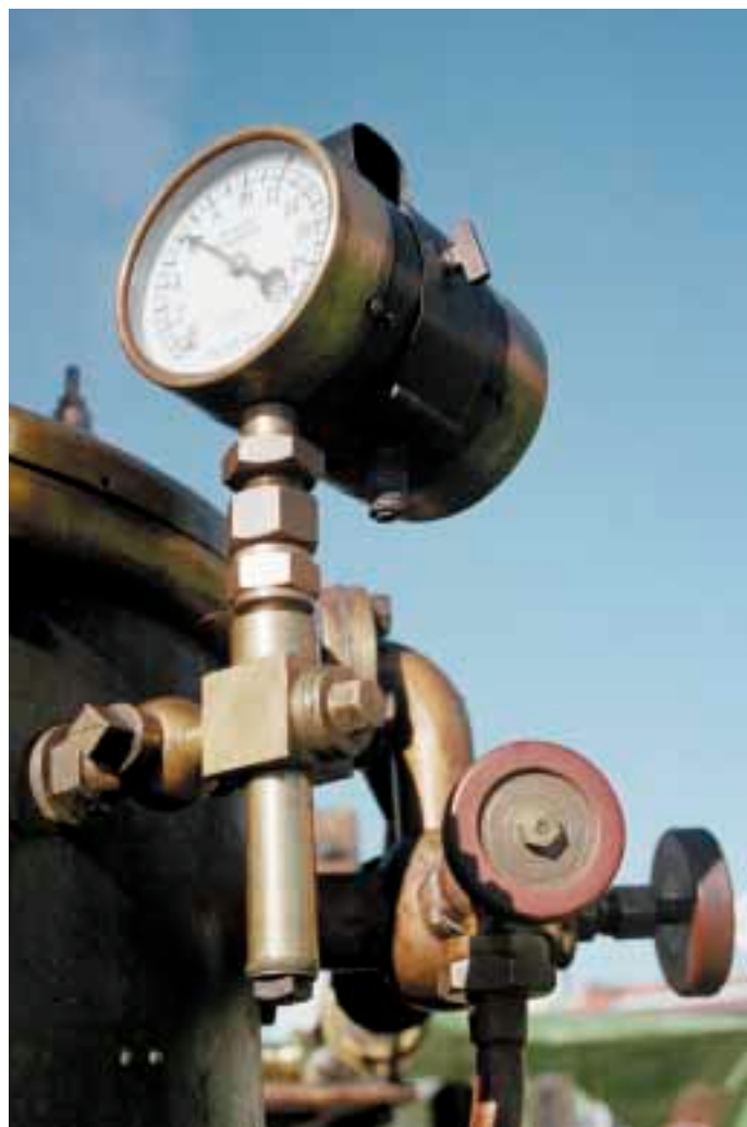
Manometr tlaku páry v kotli.
